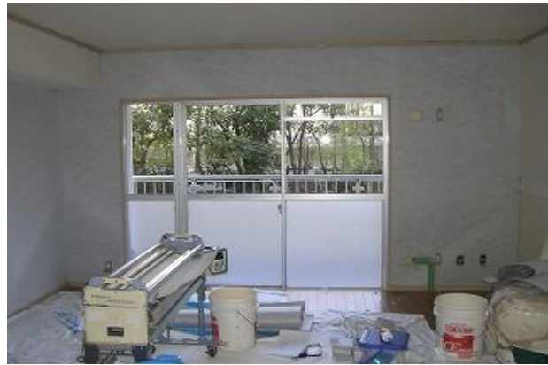
エルシート貼り完了
