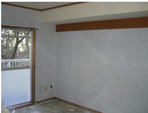
エルシート貼り状況
