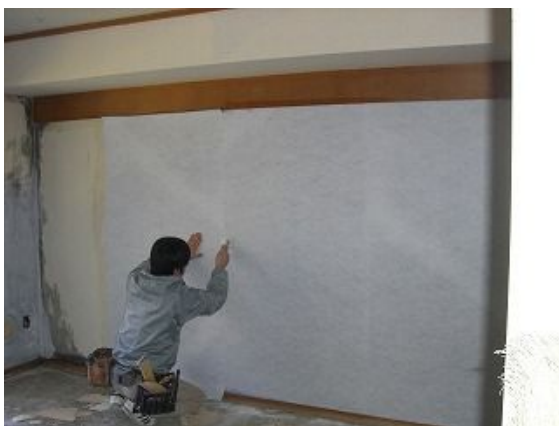
エルシート貼り状況
